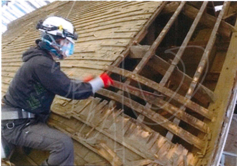
27.12.25 野地板解体状況
