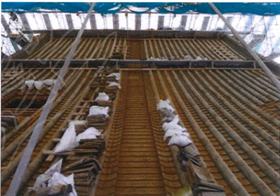
27.12.2 実測用 先行瓦解体
