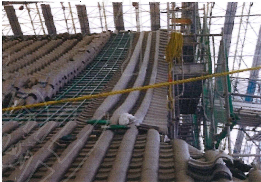
28.3.18 箕甲瓦葺工事 改修瓦が見える
