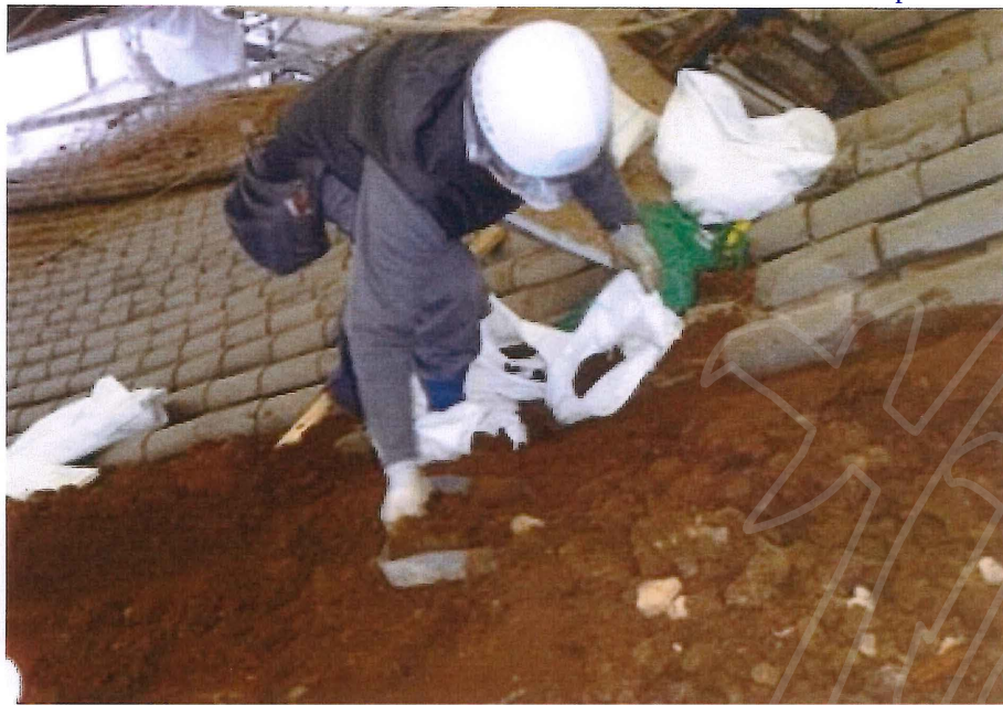
27.12.15 丸平瓦解体. かなり厚い葺土
